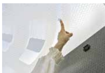
天井の換気口は、調整可能。
