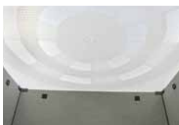
天井には採光性のある素材を使用。
